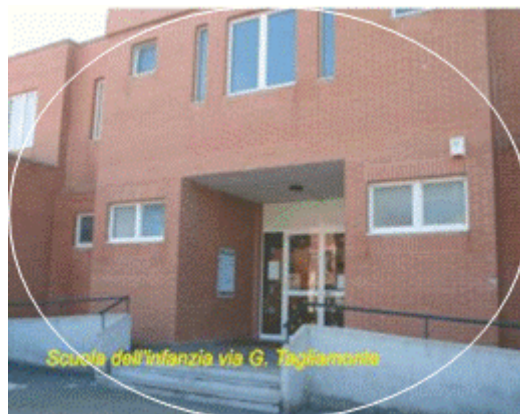
La Scuola dell'Infanzia- Via Tagliamonte, n.24 bis
