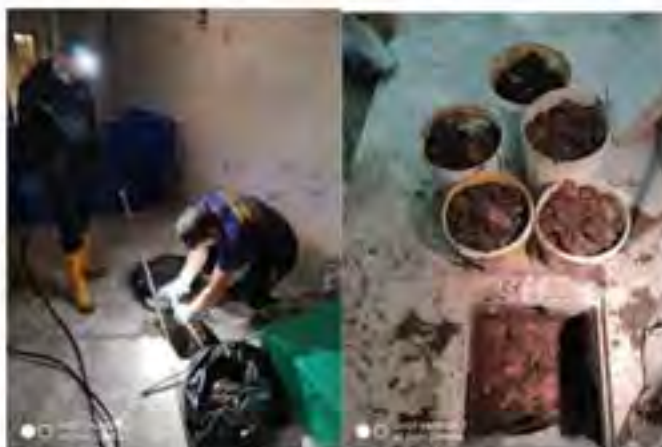
Foto: ANITA ha pagato un auto-spurgo per disostruire i tombini dell'orto interno e gli scarichi dei seminterrati, in cui confluiscono anche le acque nere dei bagni della scuola statale dell'infanzia di Via Mondovi.
