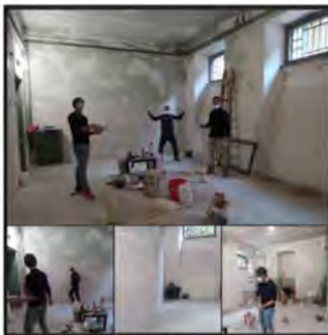
Foto: la riqualificazione della sala multifunzionale (prima e dopo).
