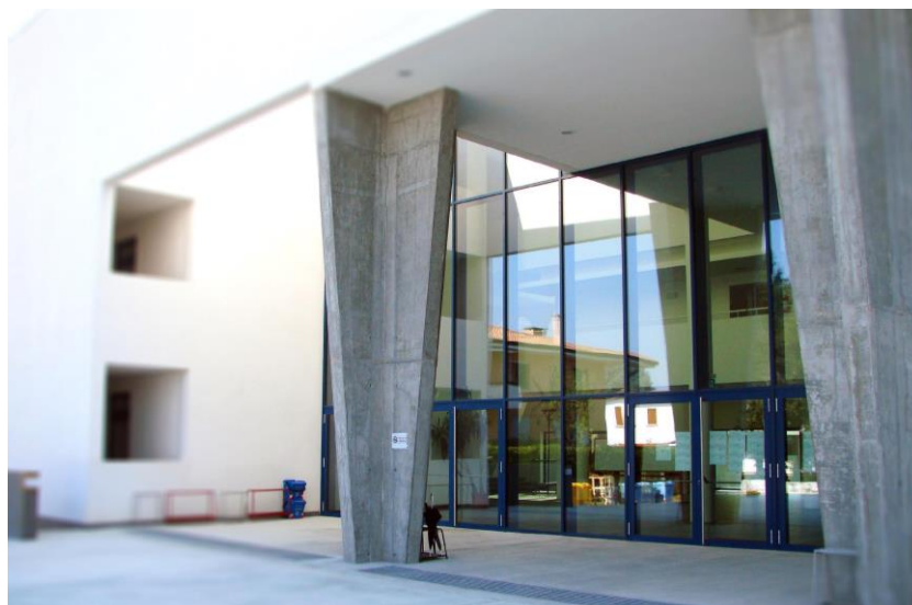
Edificio di via Sansovino, 6/a: l'ingresso nord
